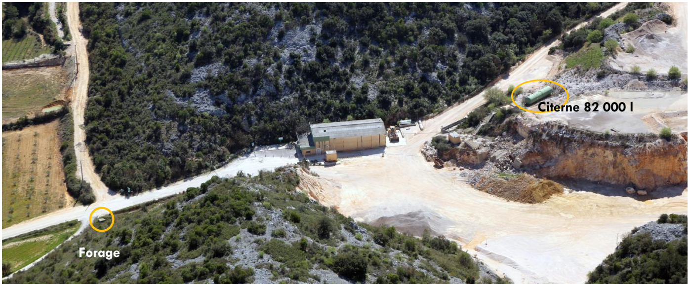
Figure 87. Vue du forage et de la cuve tampon au sein du site : PhotoCiel avril 2013
