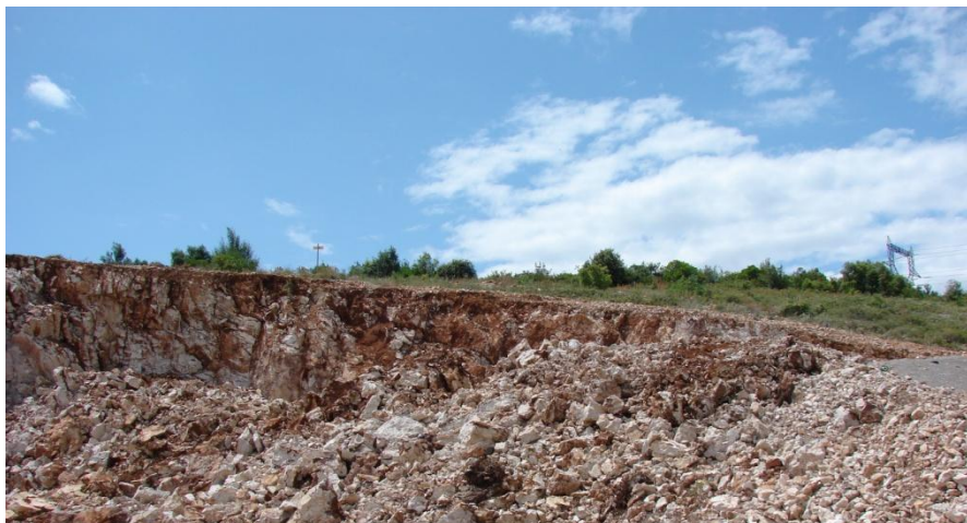
Figure 24. Le fériasol a été dégagé par les opérations de découverte. Restent les accumulations d'argile rouge dans la structure du calcaire
